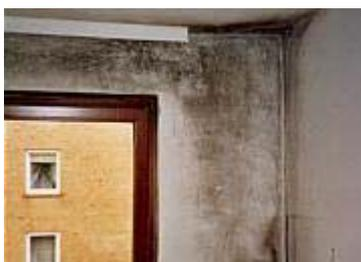
Zudem können noch Schäden am Mauerwerk, am Außenputz oder nicht rechtzeitig erkannte Rohrbrüche die Ursache für Feuchtigkeitsschäden sein.
