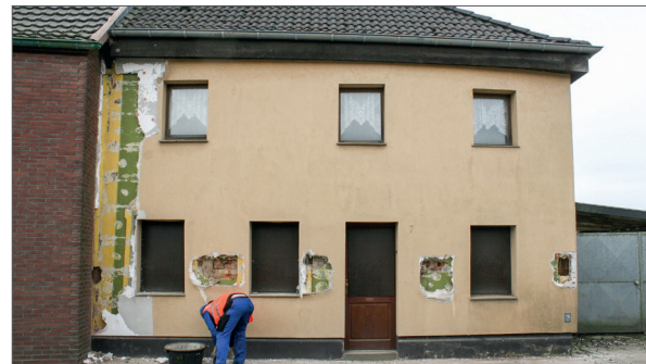
Linde Borschemich 7: Unter einer Dämmschicht und einem Zementputz des frühen 20. Jahrhunderts konnte eine Fachwerkkonstruktion von 1710 freigelegt werden. © A. Schmid-Engbrodt, März 2015.
